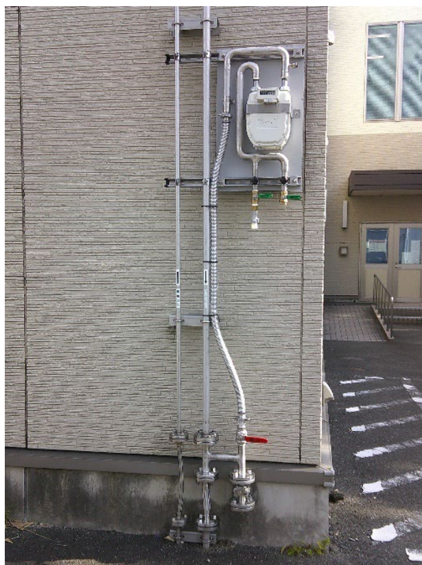
図 14 既設配管に新設した回収受入口
