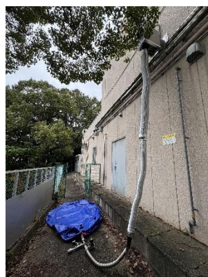
図 2 貯水袋とクエンチダクトの接続
