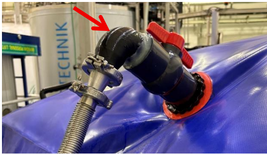
図6 作製した専用継手を接着
