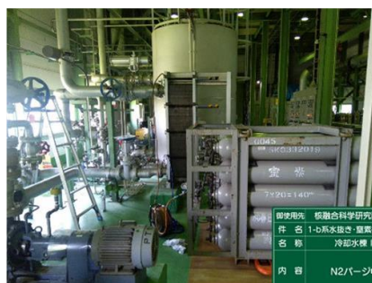
図 2. GN 2 カードルを用いた配管内の水分除去
