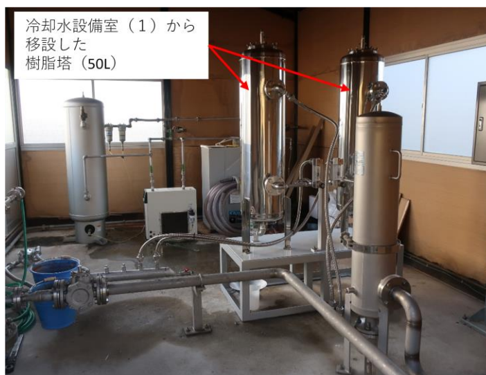
図2. 新イオン交換樹脂塔及びその配管類の設置現場 （プレハブ小屋内）
