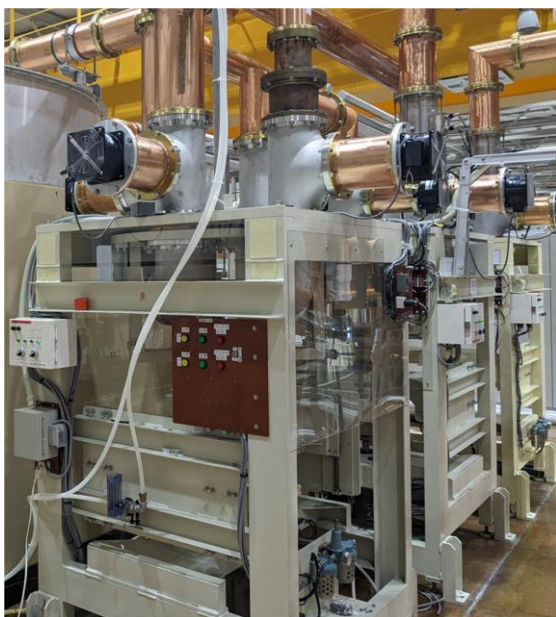
図4. 同軸切換器に取り付けた入射方向表示器
