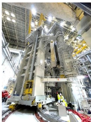
図 1. 補修中の真空容器
