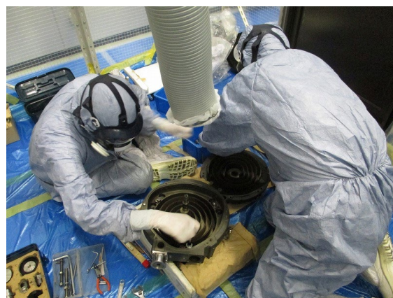
図4. スクロールポンプメンテナンス作業
