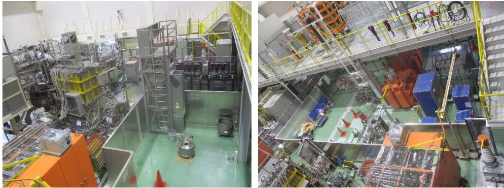
図 5. 左:作業前の様子 右:作業後の様子
