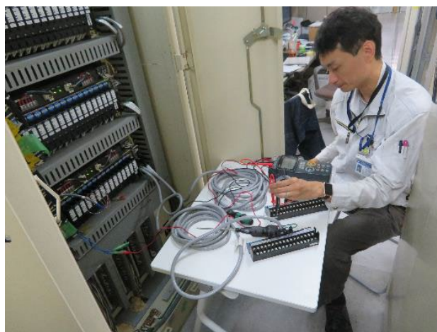
図1. 信号変換器の点検・校正
