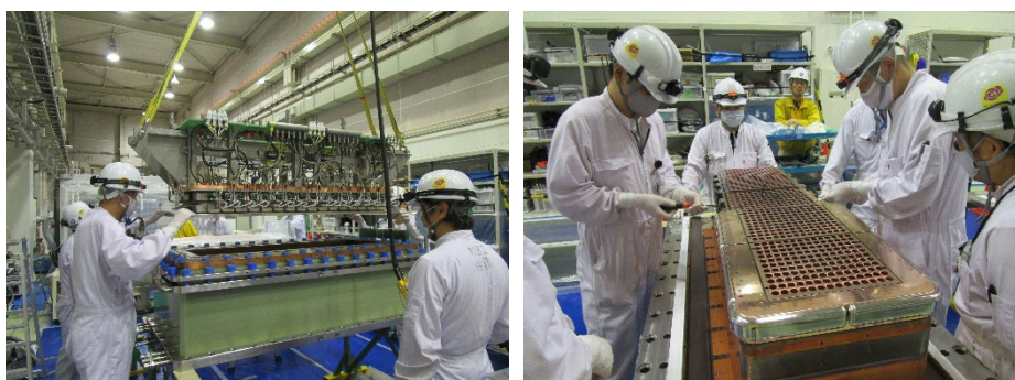
図6. アークチャンバーの切り離し（左）と電極の組み立て（右）の様子
