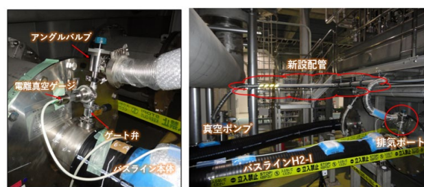
図5. バスライン真空排気系の改善結果
